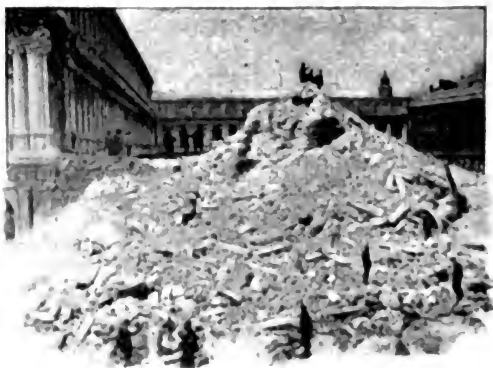
LE MACERIE DEL CAMPANILE DI SAN MARCO.
